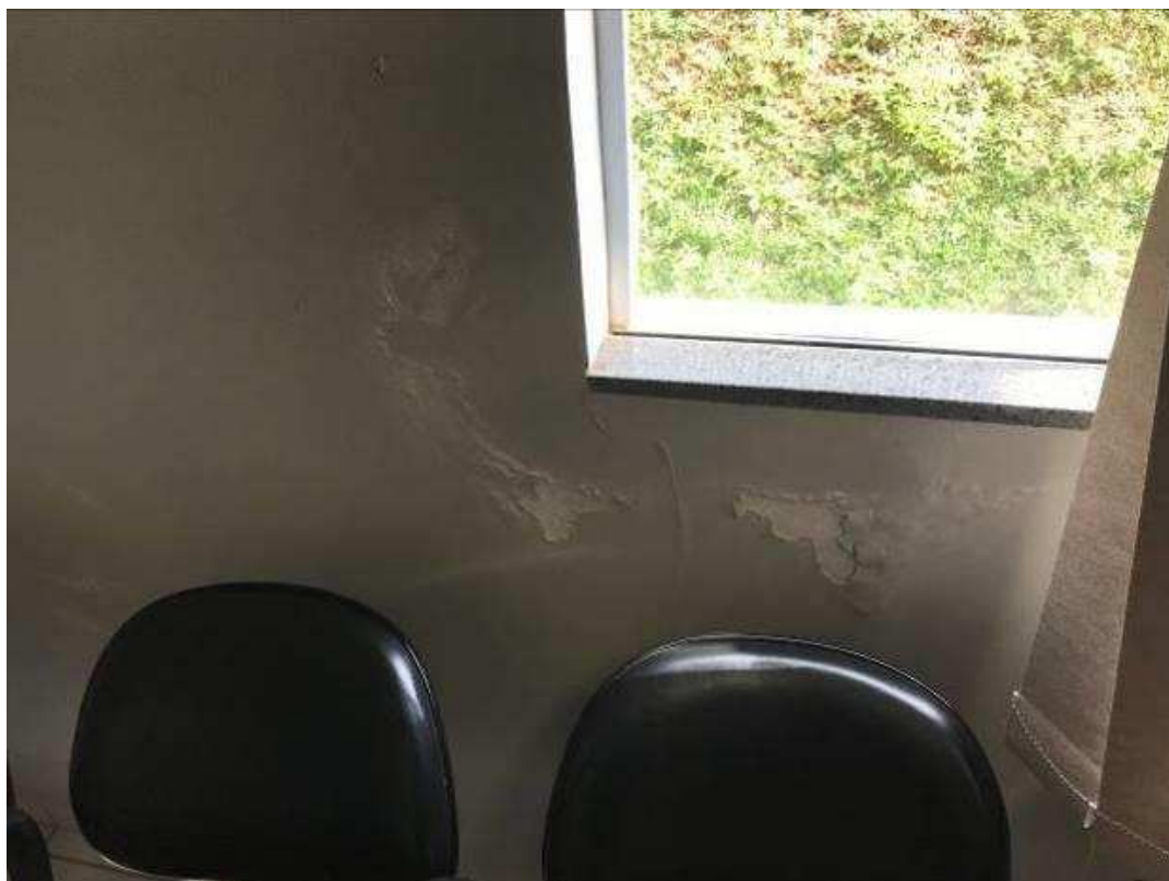
Foto 12 – Parede com infiltração
