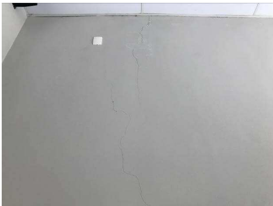
Foto 10 – Parede com trincas
