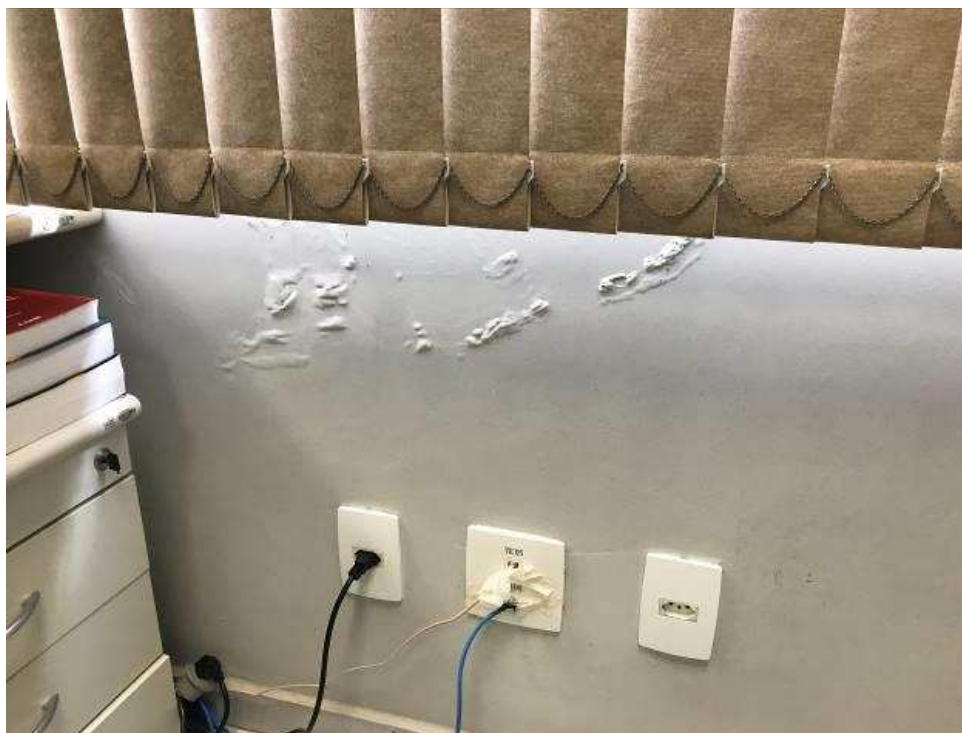
Foto 12 – Parede com infiltração
